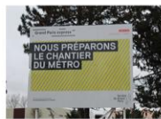
Travaux préparatoires pour la ligne 15 du Grand Paris.
